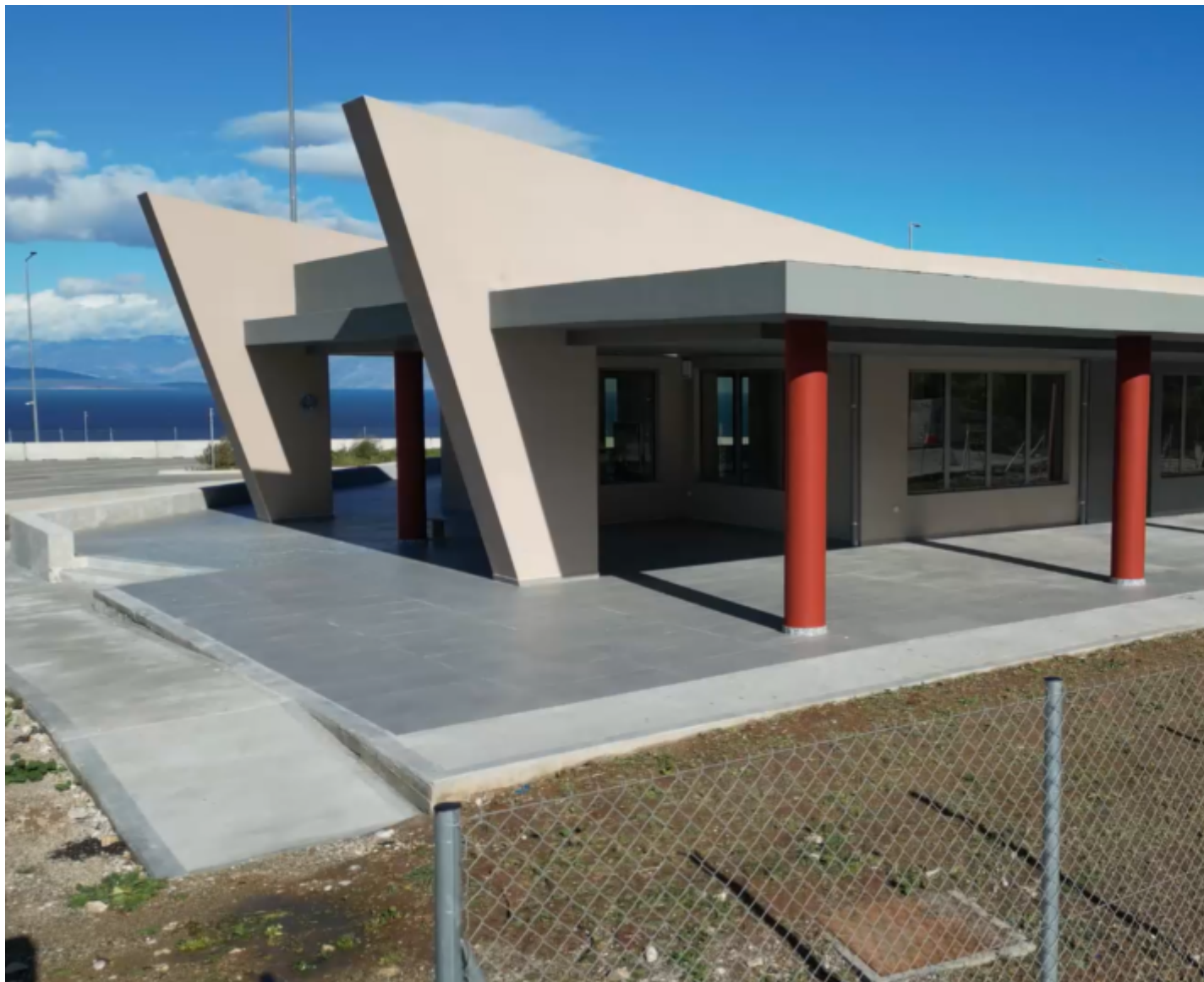
Το κεντρικό κτίριο του SSTPA της Ακράτας
