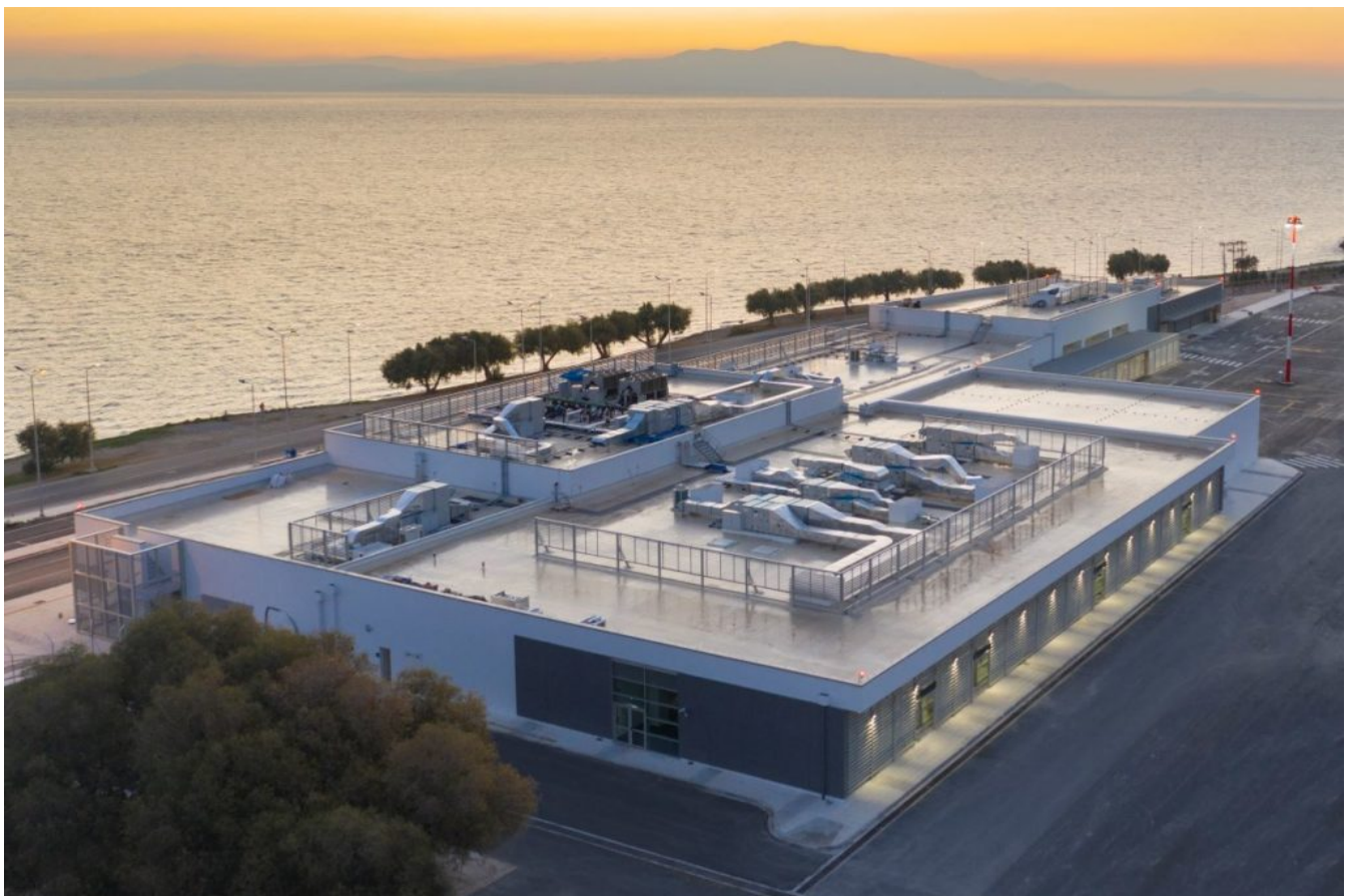
Αεροδρόμιο Μυτιλήνης: +14,9% η κίνηση στο πρώτο εξάμηνο
