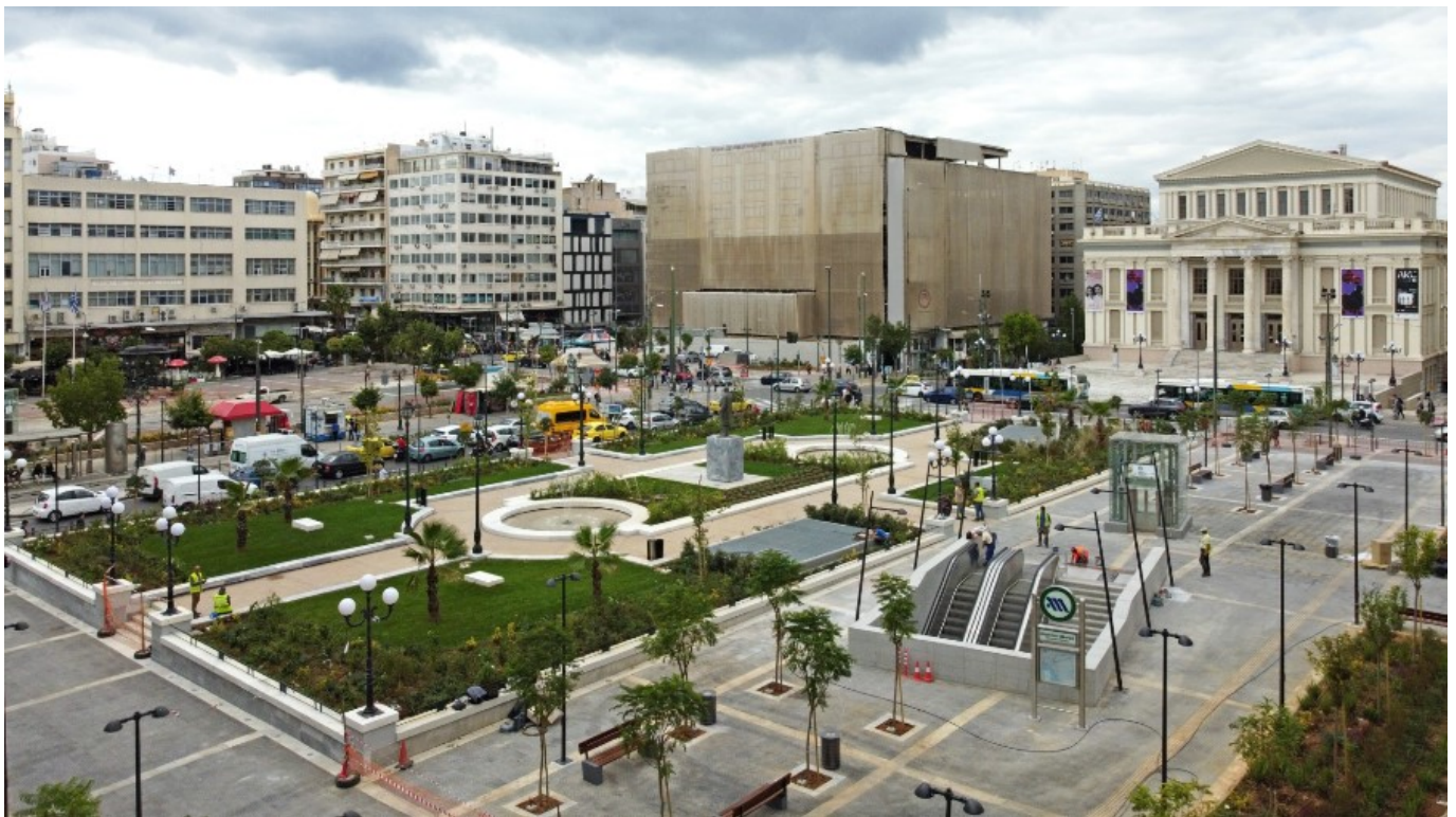
Εξωτερική άποψη του σταθμού “Δημοτικό Θέατρο”
